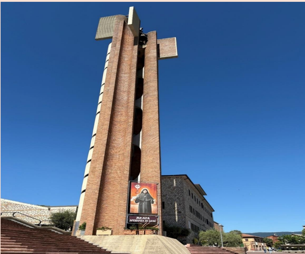
Santuario dell'Amore Misericordioso (paramento murario)
