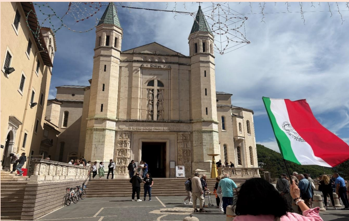
Basilica Santuario di Santa Rita da Cascia (paramento murario)
